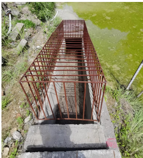
图 2.6-2 尾矿库内排水斜槽进水口
